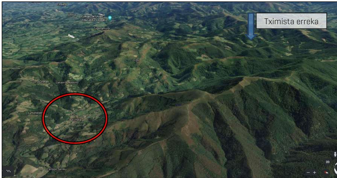
Figura 1 Vista aérea, desde aguas abajo de Etxalar, de las cuencas de las diferentes regatas que aportan sus aguas a la regata principal Tximista, que en su tramo bajo circula por el casco urbano de Etxalar. En la imagen se señala la localización, mediante un círculo de color rojo del casco urbano de Etxalar, mientras que la zona de la cabecera de las regatas que dan origen a la regata Tximista se ha señalado mediante una flecha de color azul [imagen obtenida de GoogleEarth].
