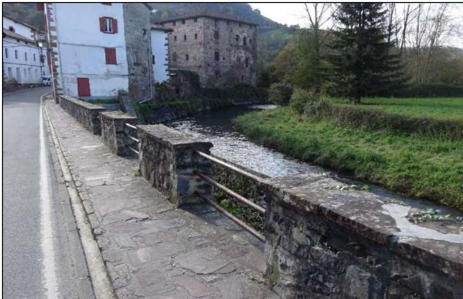
Figura 27. Fotografía de la carretera NA-4400, a su paso por el casco urbano de Etxalar. Este tramo con riesgo de verse inundado aparece señalado con el número [1] en la figura 26.
