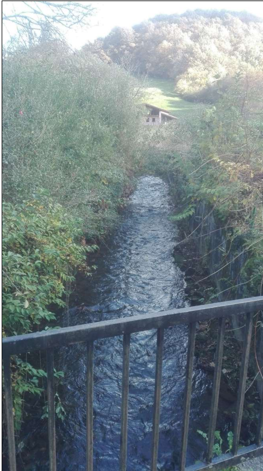
Figura 39. Fotografías tomadas en el último tramo de la regata Argarata antes de la confluencia con el Tximista. En esta zona hay varios puentes –algunos con barandillas como se muestra en la fotografía de esta página, que en caso de desbordamientos puede producir retención de troncos y ramas. Esta regata también está parcialmente canalizada en algunos de sus últimos tramos.
