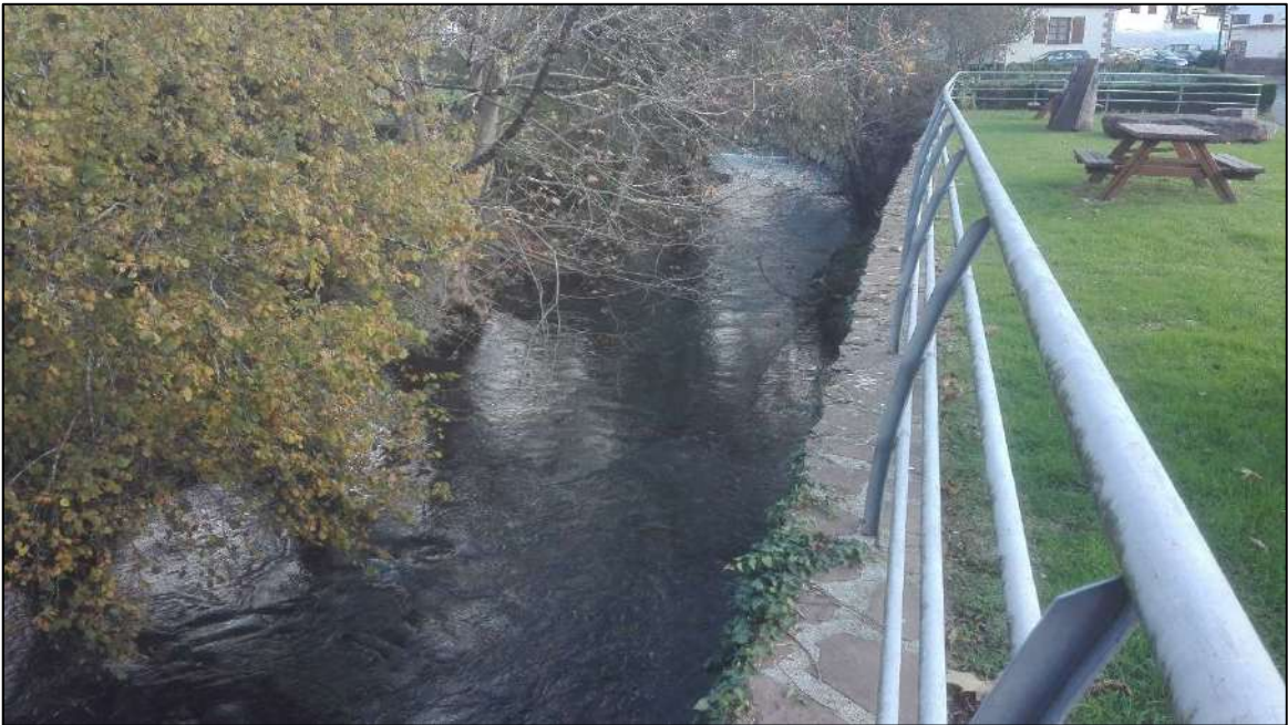
Figura 41. Vistas del cauce del río Tximista – en concreto fotografías de la margen izquierda del río – en el tramo más bajo del ARPSI de Etxalar. Se trata del tramo del Tximista, ya aguas abajo del segundo de los puentes de la carretera NA-4400 en la localidad.
