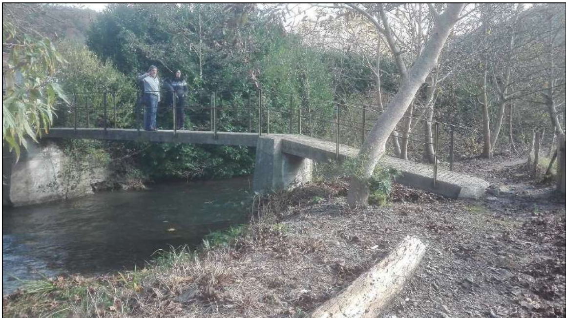
Figura 21. Fotografías tomadas durante la visita de campo realizada tras la primera reunión efectuada para la redacción de este plan. Se trata de imágenes del puente peatonal, que aguas arriba de la presa, comunica el barrio de Antsolokueta con la zona no urbanizada de la margen izquierda del río Tximista. Se trata del puente señalado con el número [2] en la figura 19.
