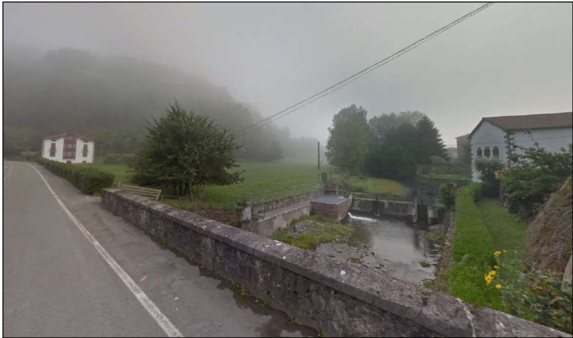
Figura 24. Imagen, obtenida de GoogleMaps, de la zona del puente de la carretera NA-4400 a la entrada del casco urbano. En la parte izquierda se pueden observar también los campos por los que se extiende la inundación en esta zona debido al efecto presa del puente y los taludes de la carretera.
