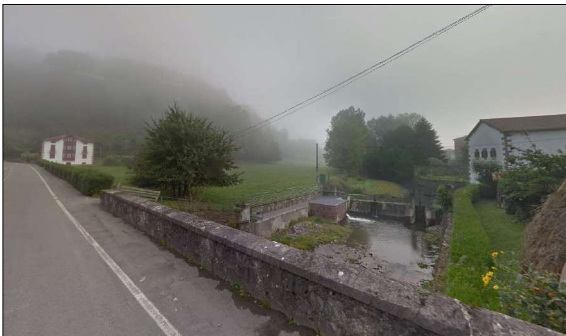
Figura 24. Imagen, obtenida de GoogleMaps, de la zona del puente de la carretera NA-4400 a la entrada del casco urbano. En la parte izquierda se pueden observar también los campos por los que se extiende la inundación en esta zona debido al efecto presa del puente y los taludes de la carretera.
